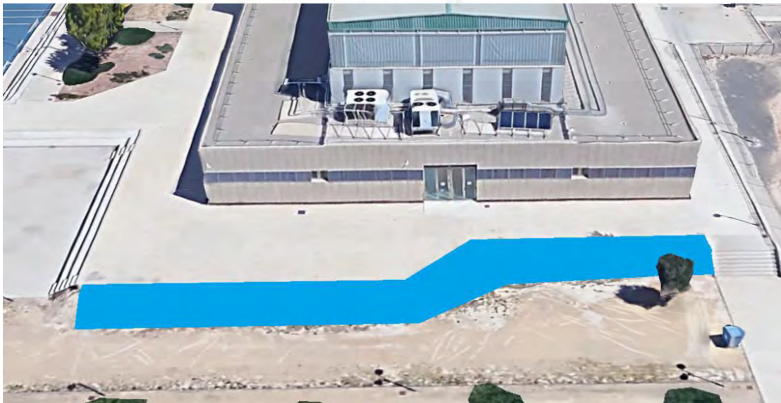
Figura nº 6. Zona donde irán colocados los biofiltros de tratamiento (muro verde). Fuente: Google Earth.
