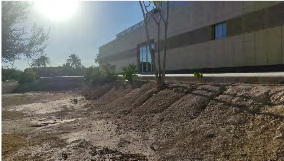
Figura n° 16. Fotografía donde se aprecia la vegetación existente antes de realizar ninguna operación en el terreno. Fuente: Elaboración propia.
