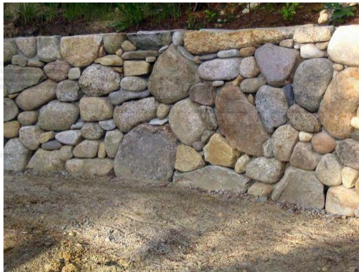
Figura n° 29. Muro seco. Fuente: Google imágenes.
