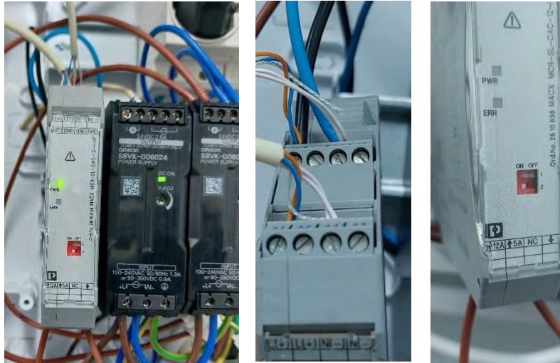
Figura 45. Detalles conexión transductor de corriente
