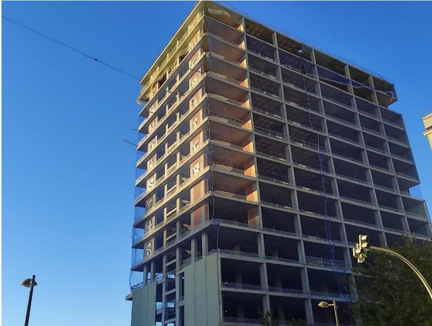
Un edificio en proceso de construcción en un barrio de Valencia | Teresa Ortega
