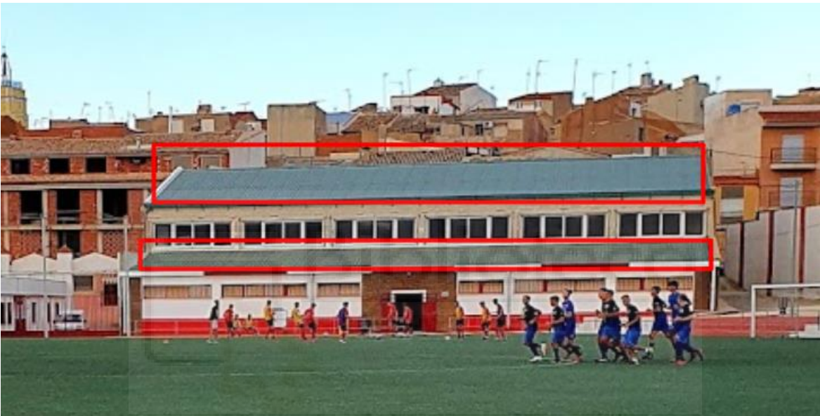
Figura 2: Cubierta donde se realiza la instalación de la obra
