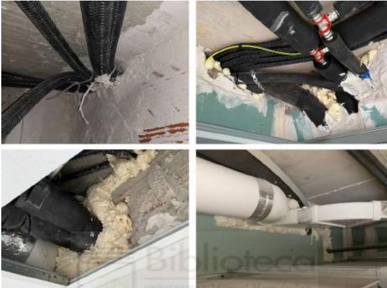
Figura 5.9: M1 Mejora básica. Sellado del paso de instalaciones. Superior sellado con enlucido de yeso. Inferior sellado con espuma de poliuretano.
