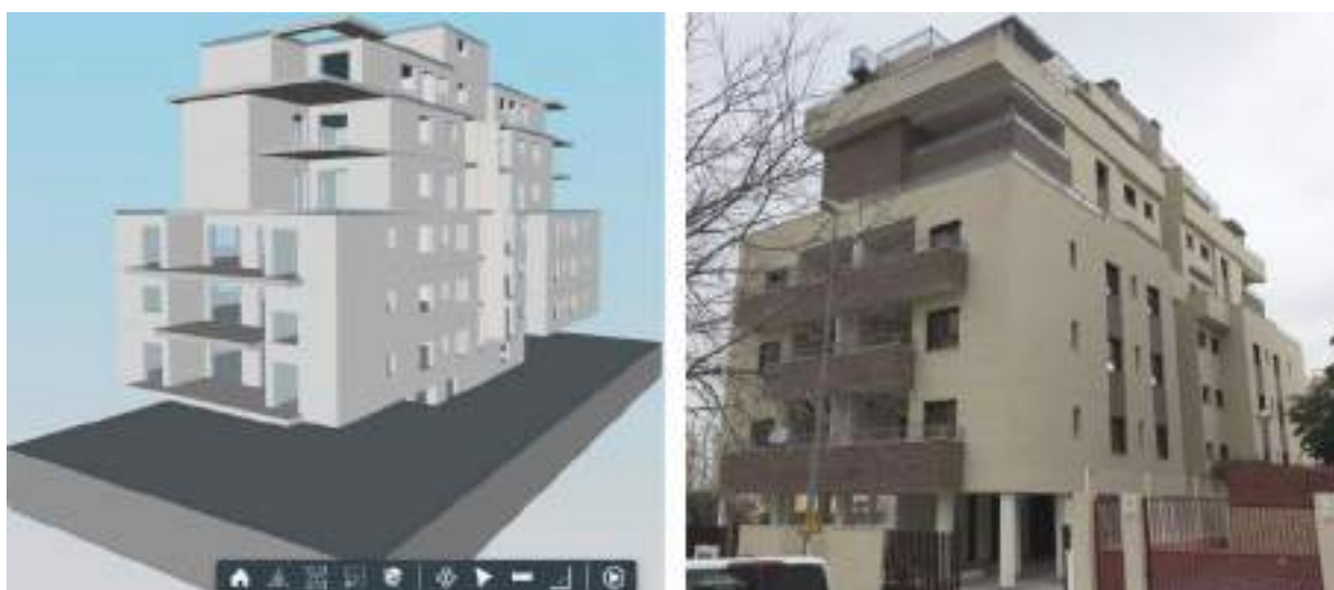
Figura 4.11: Modelo desarrollado en CYPETHERM HE Plus y edificio real.
