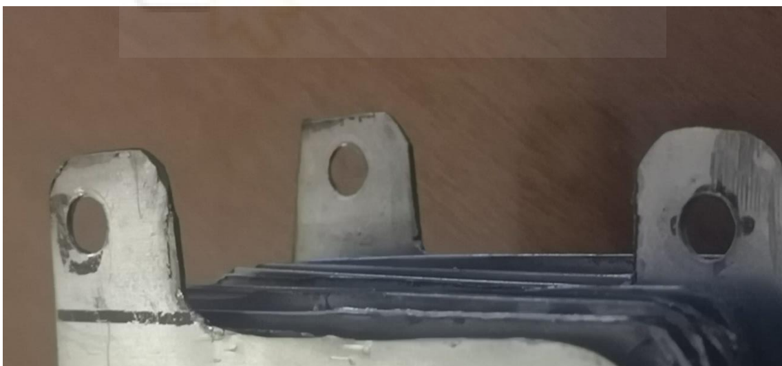
Ilustración 57: Taladros en las placas.
