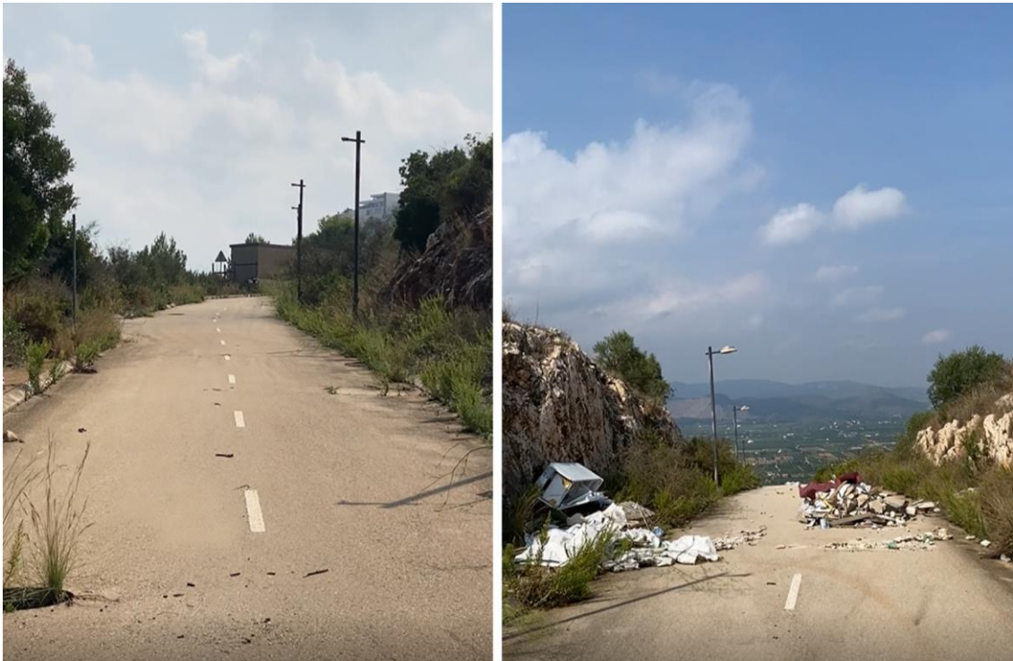
Figura 10. Fotografías de la localización A (2021). Fuente: Elaboración propia
