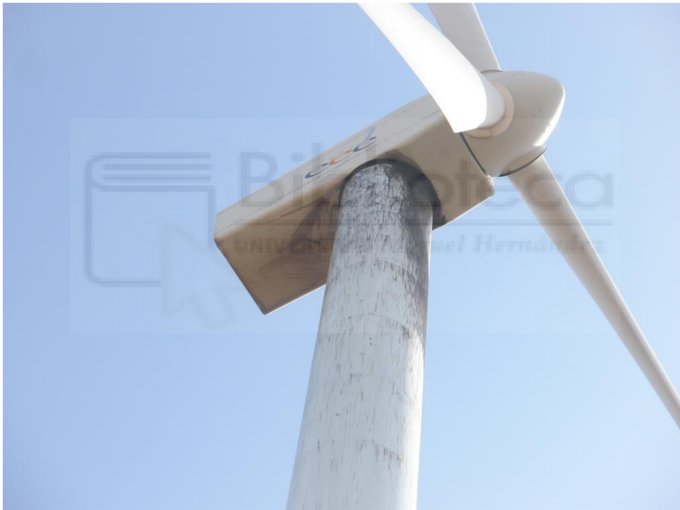
FOTO NÚM. 2: VERTIDO DE UN AEROGENERADOR
