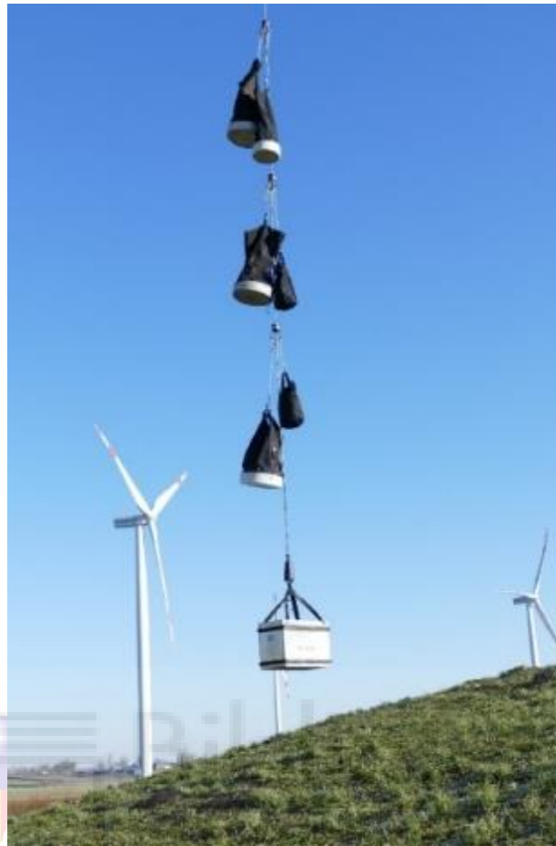
FOTO NÚM. 15: SUBIDA DE EQUIPOS Y MATERIALES.
