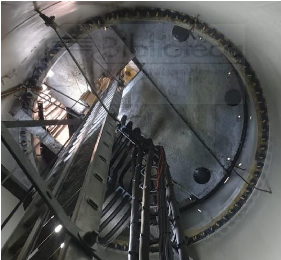
FOTO NÚM. 6: CERRAMIENTO ENTRE TRAMOS
