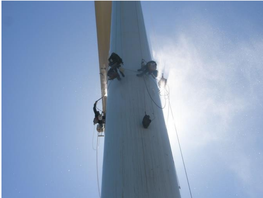
FOTO NÚM. 13: LIMPIEZA TORRE CON TRABAJADORES COLGADOS CON CUERDAS.
