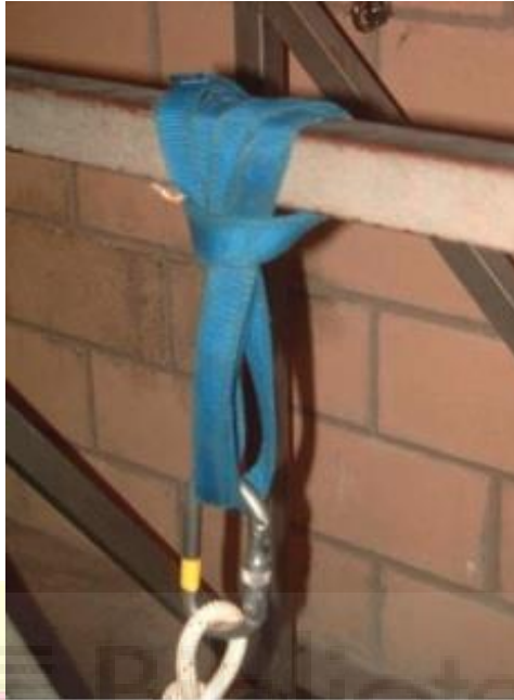
FOTO NÚM. 23: ANCLAJE CONSTRUCTIVO
