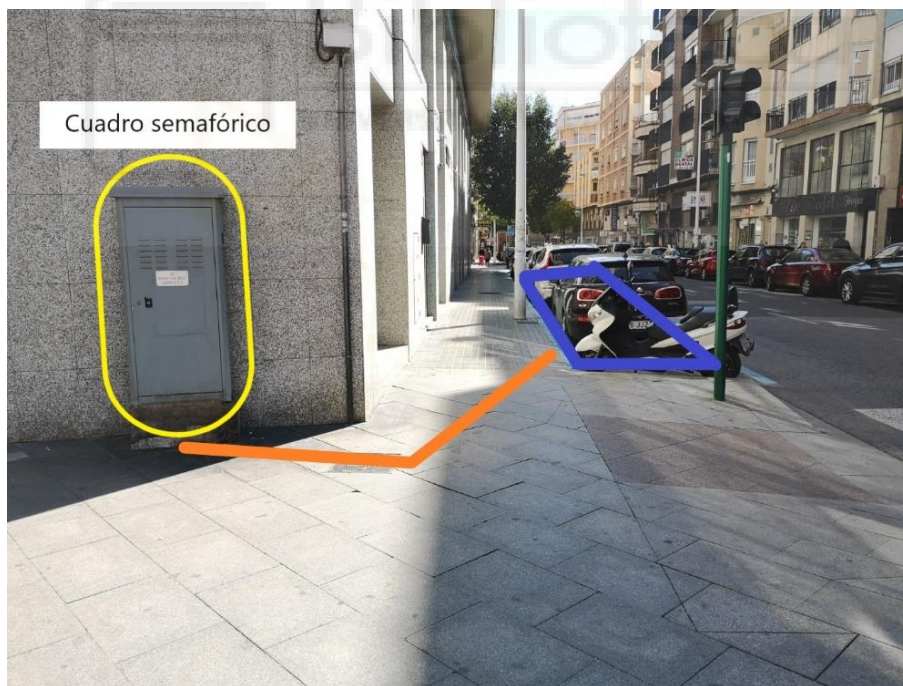
FIGURA 83: Acometida eléctrica de la estación Jorge Juan – Josep María Buck.
