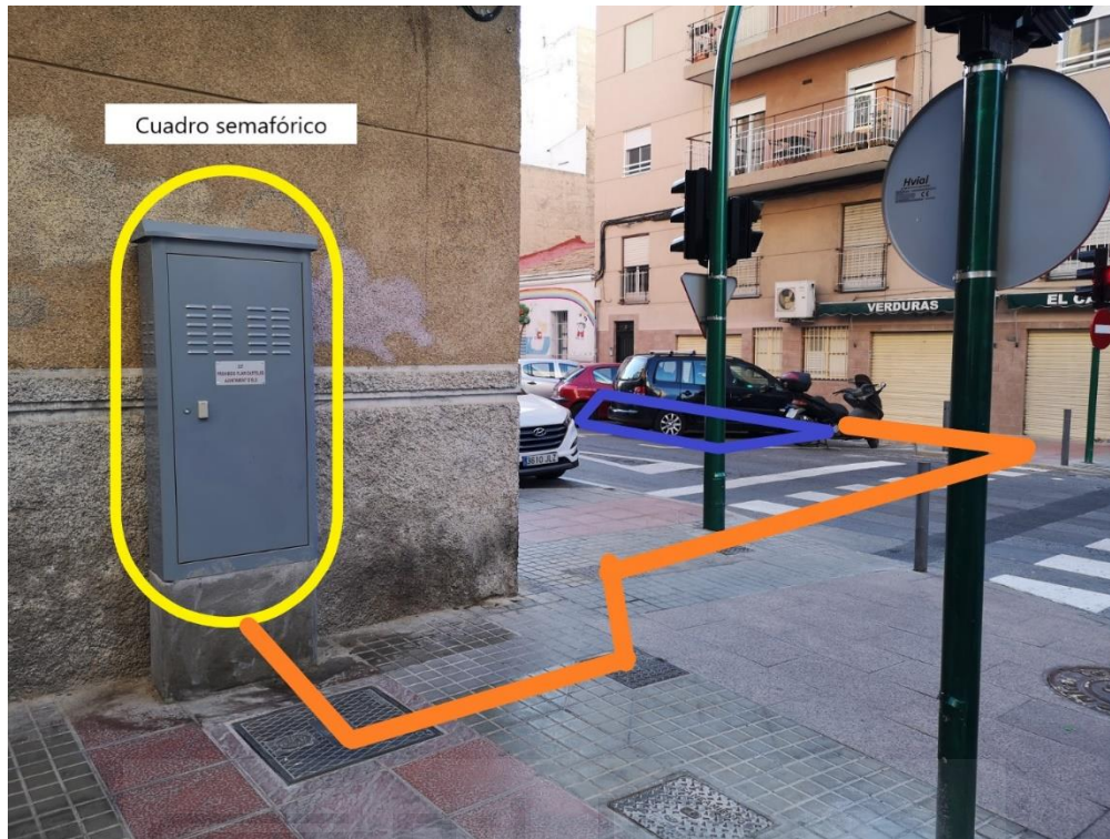
FIGURA 102: Acometida eléctrica de la estación Fernanda Santamaría – Espronceda.
