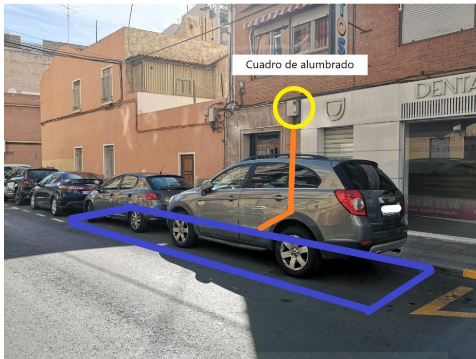
FIGURA 176: Acometida eléctrica de la estación Bisbe Winibal.
