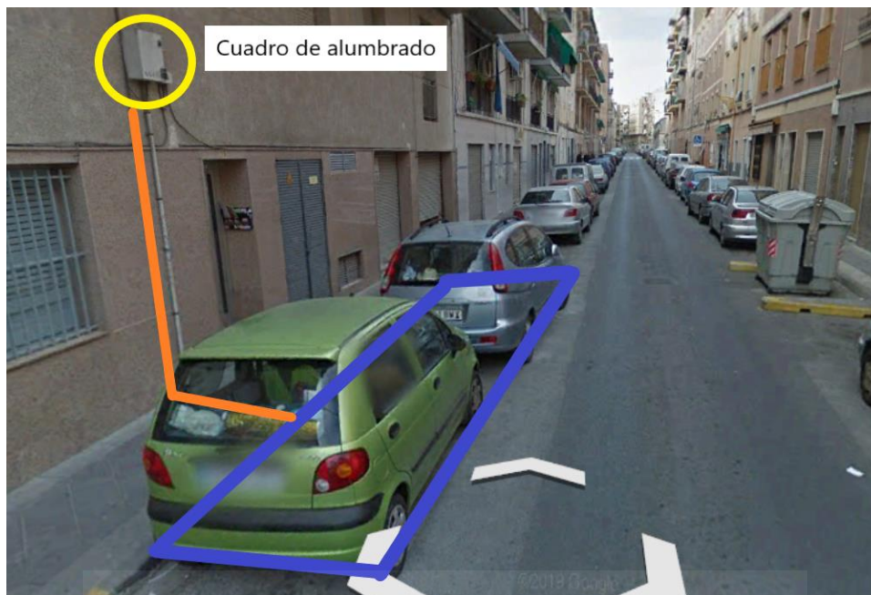
FIGURA 54: Acometida eléctrica de la estación Arturo Salvetti Pardo.
