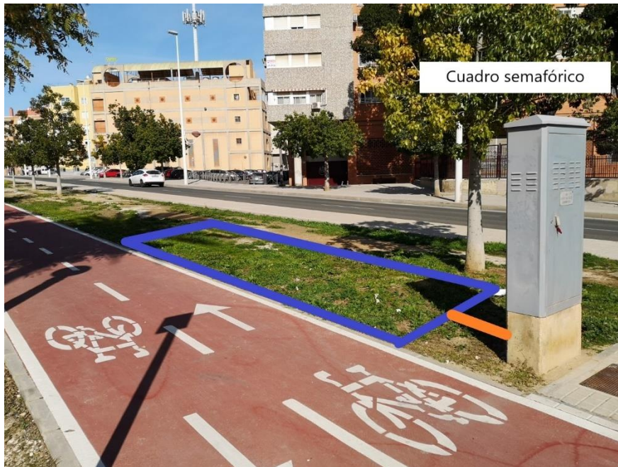
FIGURA 111: Acometida eléctrica de la estación CEIP Sanchis Guarner.
