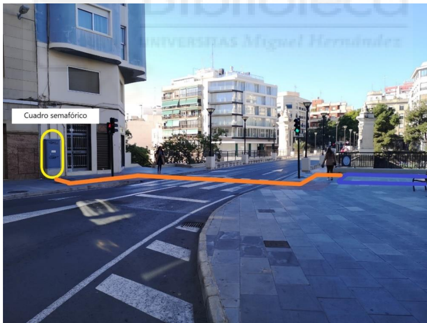
FIGURA 137: Acometida eléctrica de la estación Puente de Santa Teresa.
