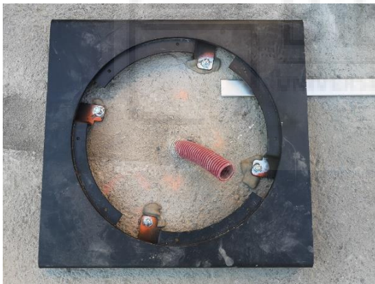
FIGURA 25: Anclaje al suelo de la base del módulo PIM.
