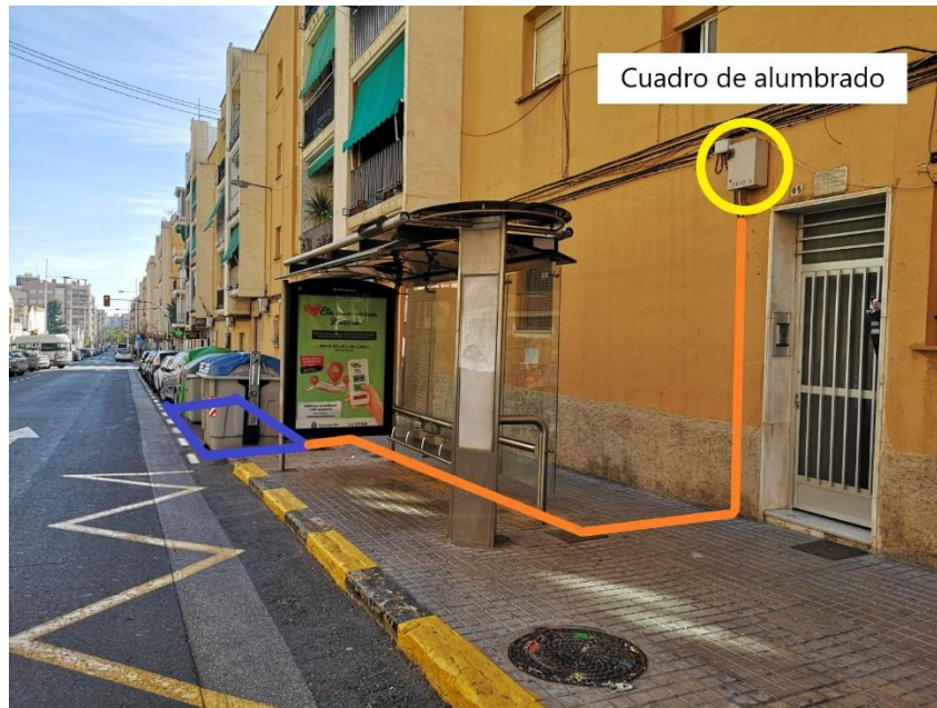
FIGURA 45: Acometida eléctrica de la estación C.P. El Toscar.
