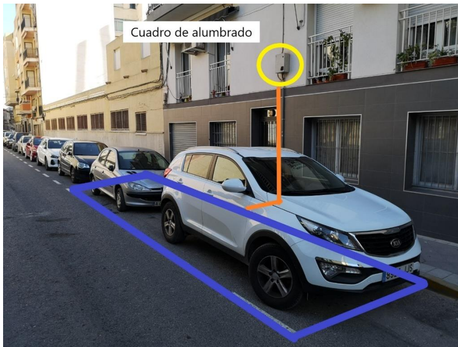
FIGURA 42: Acometida eléctrica de la estación Jardín 25 de Abril.
