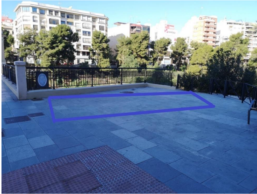
FIGURA 136: Ocupación a pie de calle de la estación Puente de Santa Teresa.
