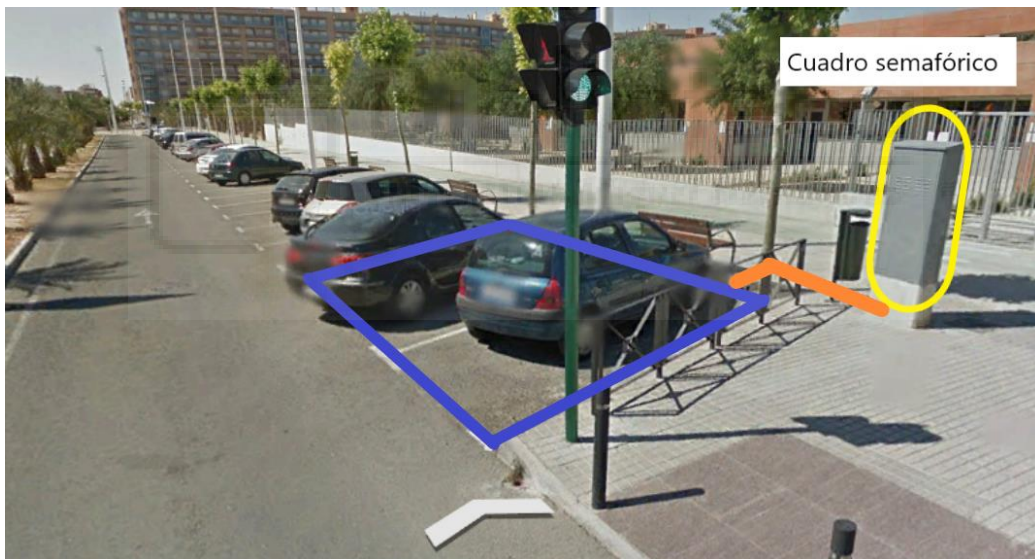
FIGURA 161: Acometida eléctrica de la estación CEIP Clara Campoamor.
