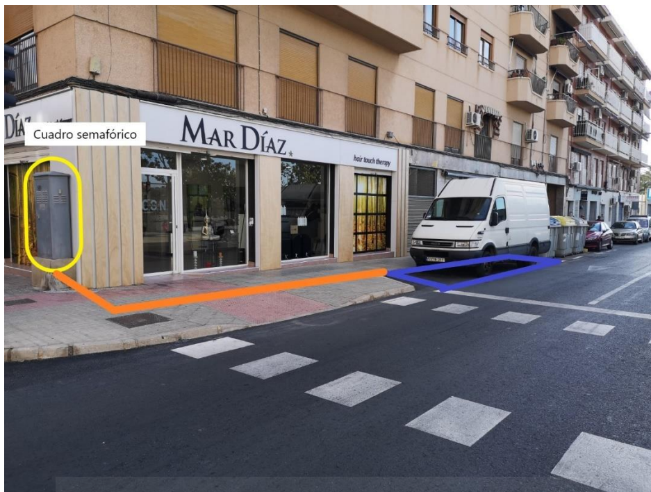
FIGURA 114: Acometida eléctrica de la estación Pistas del Pla.
