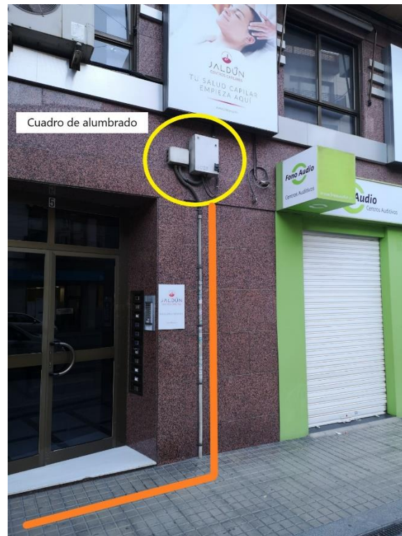
FIGURA 87: Cuadro de alumbrado de la estación Gabriel Miró – Reina Victoria.
