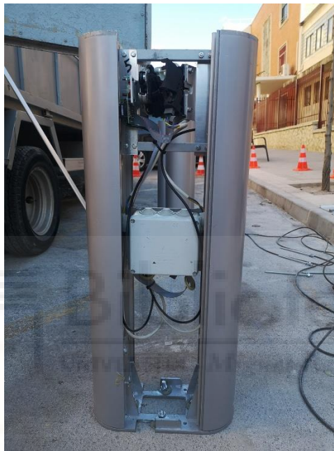
FIGURA 27: Anclaje de un módulo esclavo.
