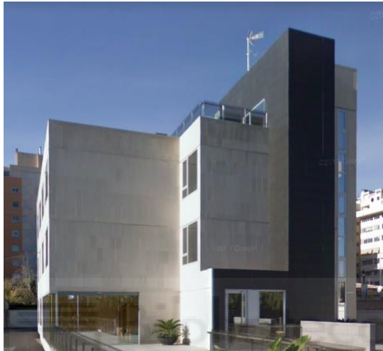
Figura 7: vista frontal del edificio
