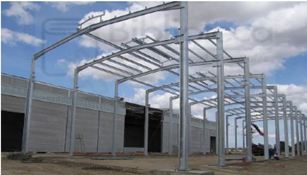
Figura 7: Estructura plana porticada rígida
