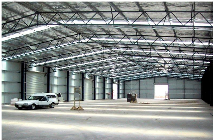
Figura 9: Estructura celosías trianguladas de barras y nudos
