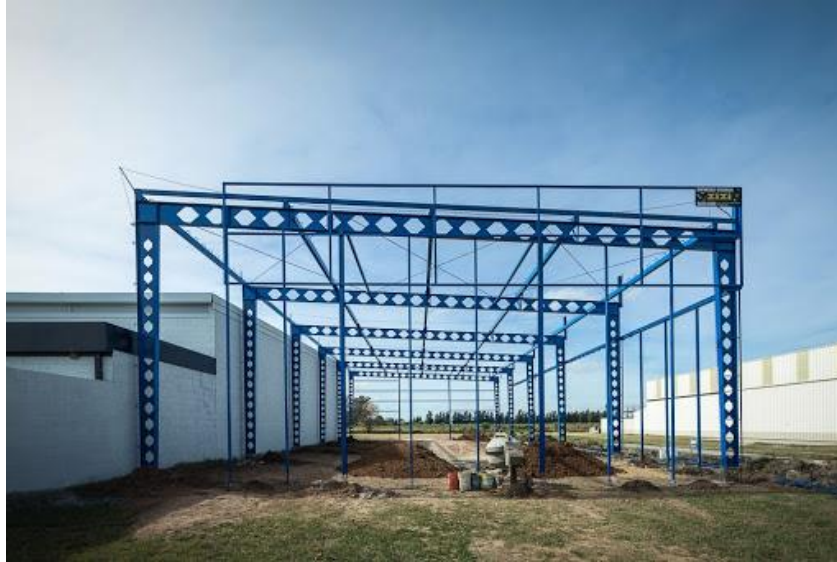
Figura 10: Estructuras con vigas y pilares alveolares
