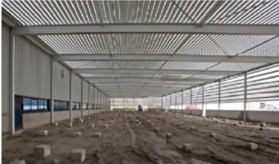
Figura 8: Estructura plana porticada articulada
