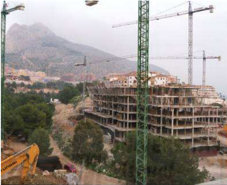
Foto de construcción dentro de un barranco aguas residuales.
