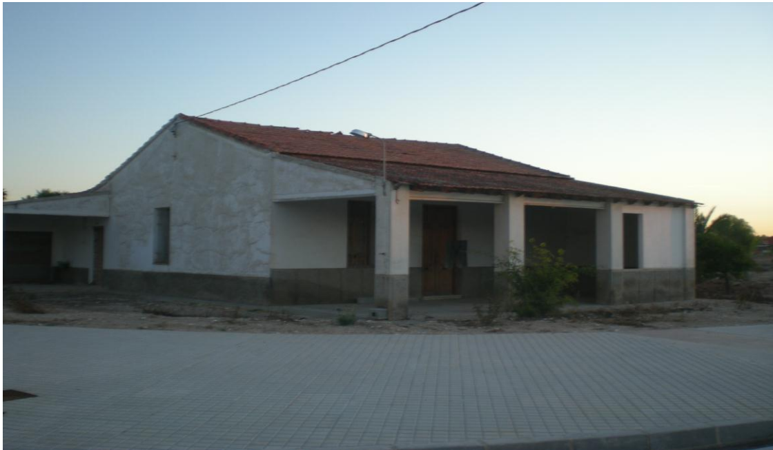
Figura 124.- Vivienda unifamiliar del campo de Elche, visión actual; se intenta destacar el aislamiento de la vivienda, no hay otras casas en los alrededores. Fotografía del autor.
