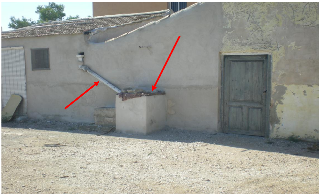
Figura 126.- Vivienda actual en la Partida de Alzabares Bajo, con recogida de aguas pluviales a aljibe adyacente a la casa; las flechas señalan el canalón y la tapa del aljibe. Fotografías del autor
