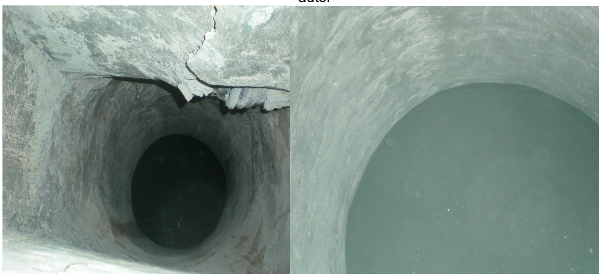
Figura 127.- Visión actual de un pozo de aguas pluviales en una vivienda de la partida de Maitino. Fotografías del autor.
