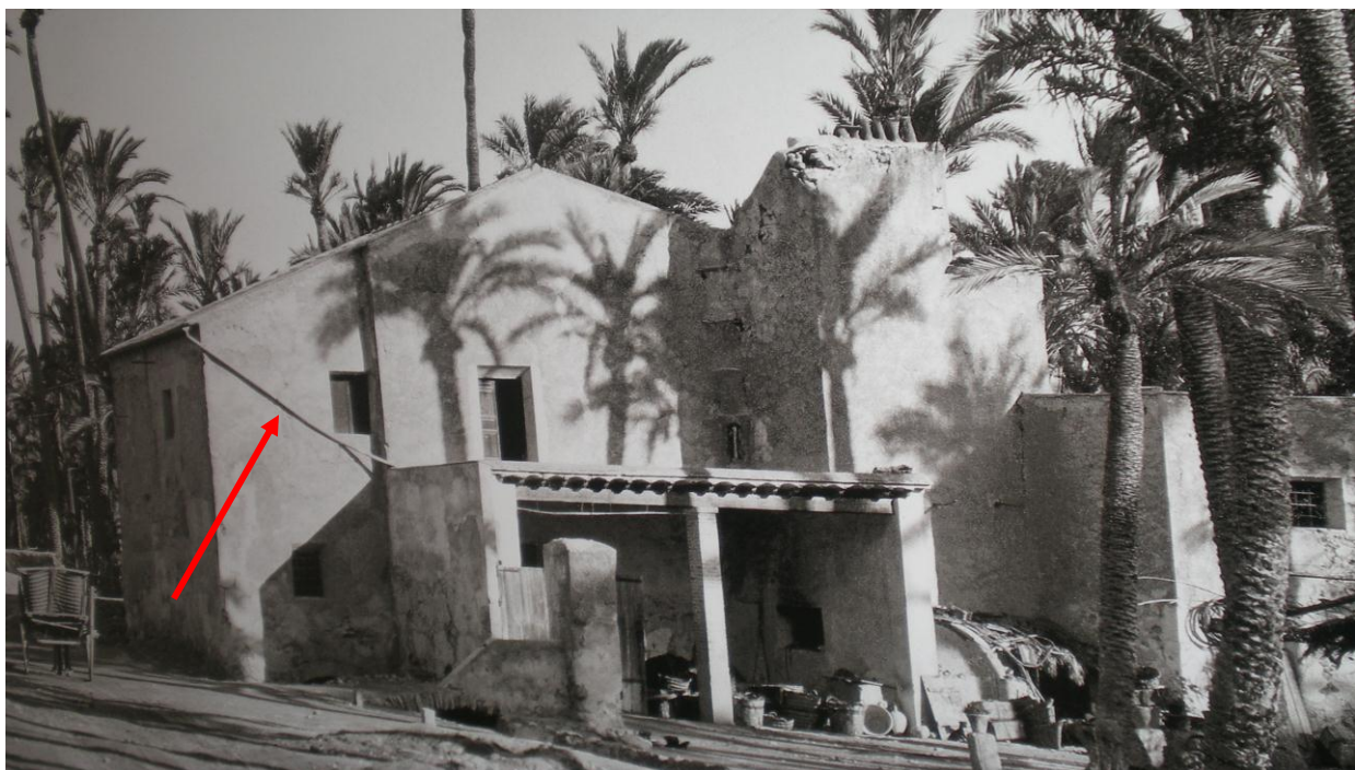
Figura 125.- Fotografía antigua de vivienda rural del campo de Elche; la flecha señala el canalón de recogida de agua de lluvia
