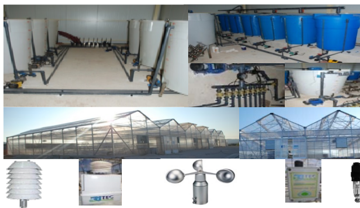
Fotografía 4.1. Vista parcial del invernadero donde se realizó el experimento y de los sistemas de riego y sensores de temperatura, humedad y radiación.
