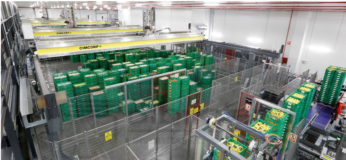
Imagen 5. Sistema PPG (Picking Puente Grúa) de Mercadona.
