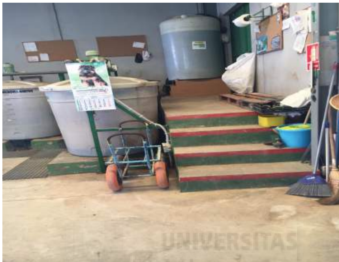
Foto 17: Escalera acceso a tanques de productos de abono
