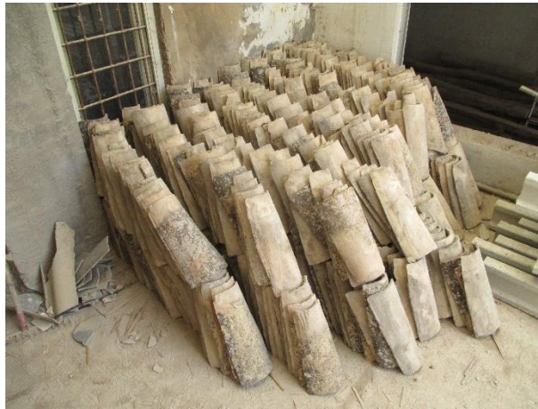
Acopio de la teja retirada de la cubierta existente.
