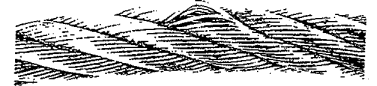
Cliché 11 - Un sólo cordón es afectado por la extrusión de los hilos, aunque el examen de una mayor longitud del cable muestra que el defecto se repite regularmente sobre el mismo cordón a distancias de un paso.
