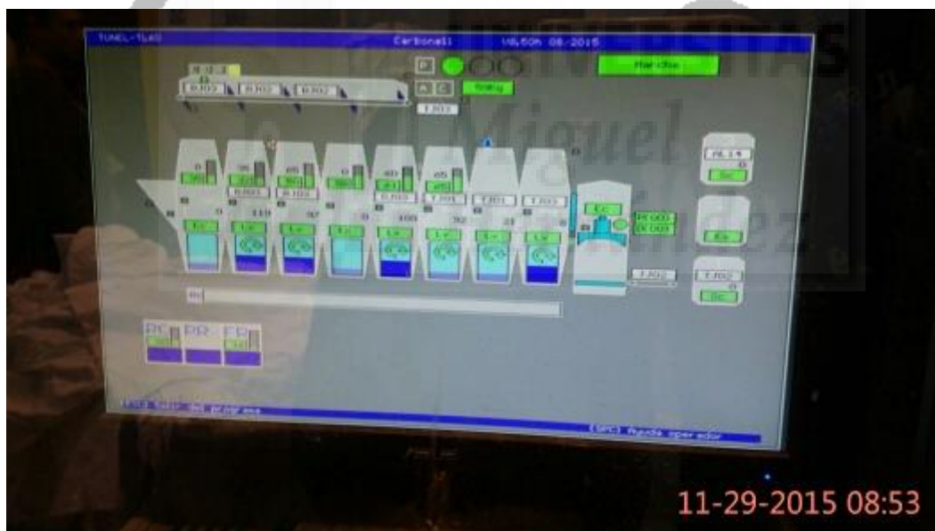
Figura 63. Túnel de lavado
