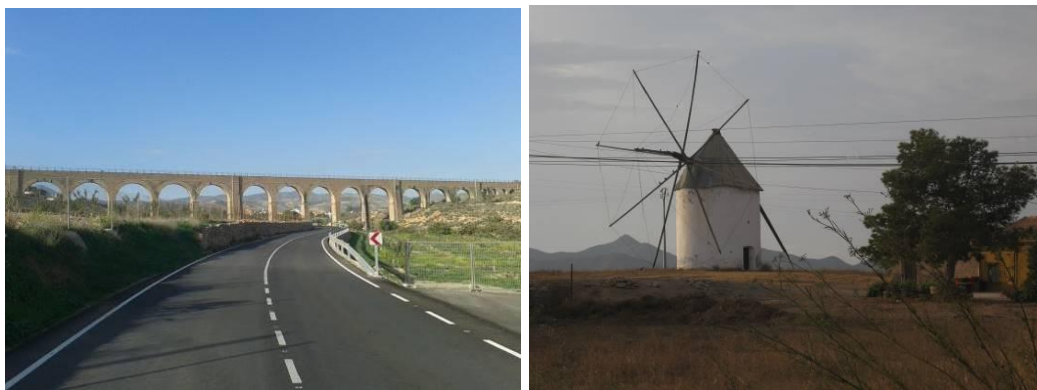
Foto nº 14. Acueducto de Perín y Molino de Cuesta Blanca
