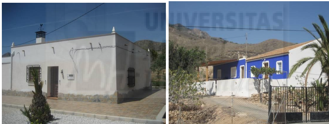
Foto nº 37. Reciente rehabilitación de vivienda de cubierta plana en La Torre de Nicolás Pérez y de cubierta “a dos aguas” en Los Fuentes
