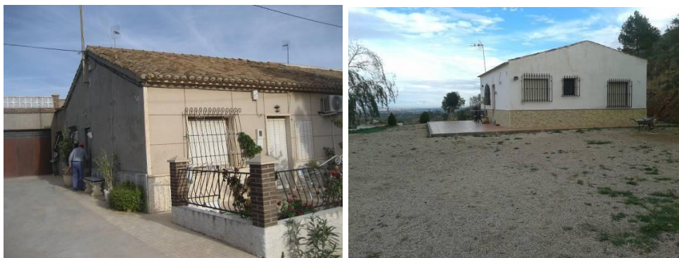
Foto nº 31. Viviendas a “dos aguas” en Las Gabinas y Los Liartes
