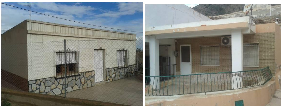
Foto nº 30. Viviendas de cubierta plana en Los Liartes y en El Portús
