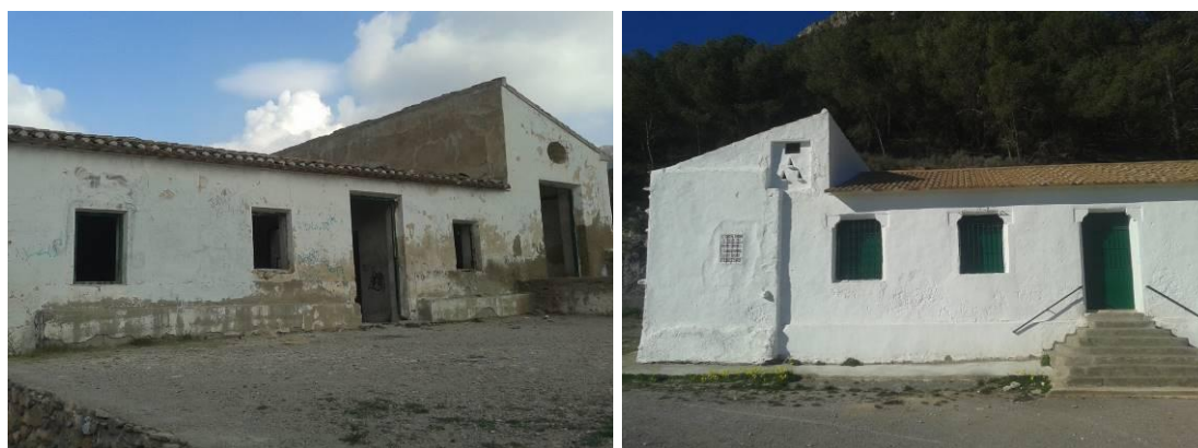
Foto nº 13. Capilla y caserío de la Rambla del Cañar (en semiruina) y de La Muela
