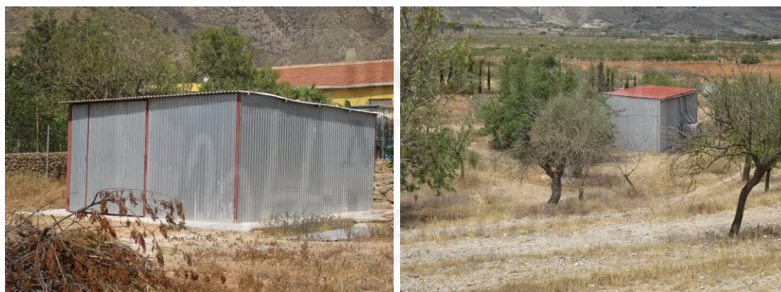
Foto nº 40. Nuevas construcciones en materiales metálicos en Torre de Nicolás Pérez y Los Martínez de Tallante
