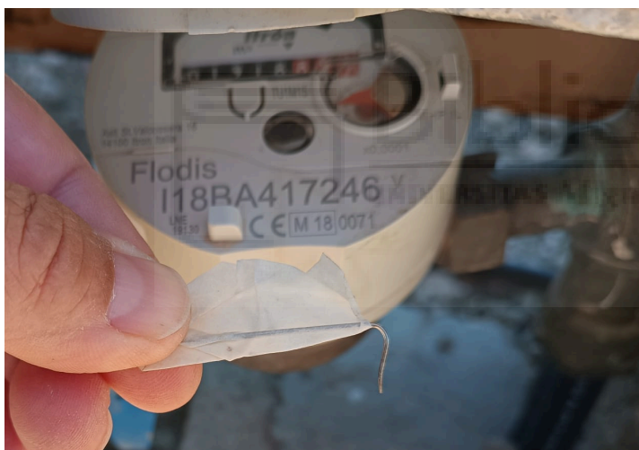
Figura 6 Mecanismo de alambre utilizado para la paralización del sistema de lectura
