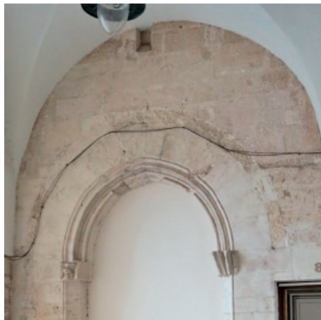
D'esquerra a dreta: Fig. 14. L'obra del claustre del segle XVIII adossa sobre un mur de l'església gòtica. Fig. 15. Mur preexistent al claustre, transformat en façana al segle XIX. Fig. 16. Antic mur que tancava el claustre per la seua façana al nord, on es va obrir l'accés des del carrer Sant Tomàs. Mur de carreus amb una grossària de 0,525 m.
