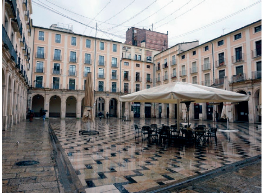
Dalt, a l'esquerra, Fig. 3. Aplacat amb llosa de pedra en reforma del segle XX. A l'esquerra d'aquestes línies, Fig. 4. Carreus originals amb mòdul irregular, possiblement per procedir d'obra anterior. A la dreta de les anteriors Fig. 5. El paviment actual de la plaça, de 1985, es combina amb lloses del tipus emprat en 1857, procedents de la Serra dels Plans o del Rontonar, amb mesures diverses que en origen devien ser superiors a dos pams valencians.
