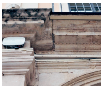
D'esquerra a dreta i de dalt a baix, Fig. 6: Voltes conservades del claustre del segle XVIII en l'entrada a la Plaça de Dins des del carrer Sant Tomàs. Fig. 7: Detall de peça possiblement reaprofitada (esquerra) amb dentícul incomplet. Fig. 8: Encontre d'obra original (dreta) i reconstrucció del segle XX (esquerra). Fig. 9: Mènula decorativa, possiblement d'un antic forjat.
