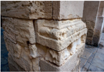
Dalt, a l'esquerra, Fig. 3. Aplacat amb llosa de pedra en reforma del segle XX. A l'esquerra d'aquestes línies, Fig. 4. Carreus originals amb mòdul irregular, possiblement per procedir d'obra anterior. A la dreta de les anteriors Fig. 5. El paviment actual de la plaça, de 1985, es combina amb lloses del tipus emprat en 1857, procedents de la Serra dels Plans o del Rontonar, amb mesures diverses que en origen devien ser superiors a dos pams valencians.
