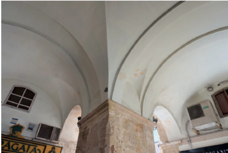
D'esquerra a dreta i de dalt a baix, Fig. 6: Voltes conservades del claustre del segle XVIII en l'entrada a la Plaça de Dins des del carrer Sant Tomàs. Fig. 7: Detall de peça possiblement reaprofitada (esquerra) amb dentícul incomplet. Fig. 8: Encontre d'obra original (dreta) i reconstrucció del segle XX (esquerra). Fig. 9: Mènula decorativa, possiblement d'un antic forjat.
