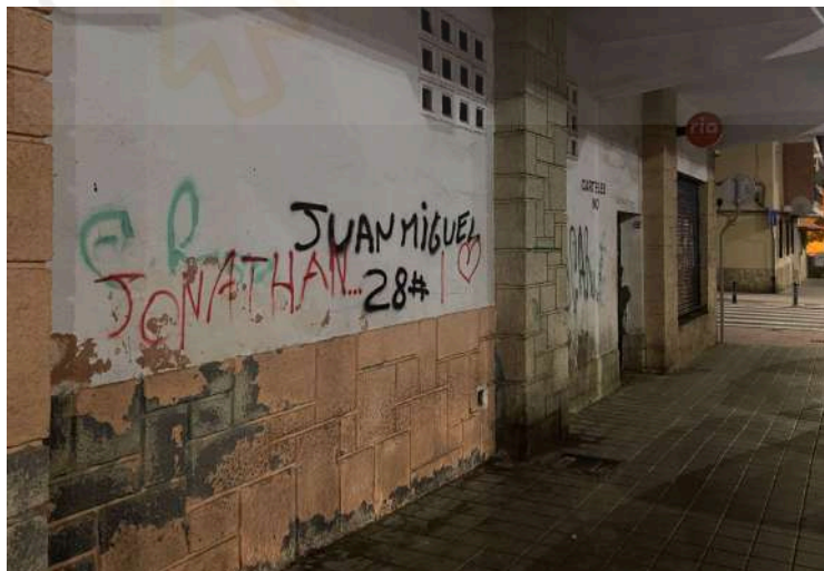
Imágen nº15. Fachada de un edificio en el barrio Virgen del Remedio Fuente: Elaboración propia.
