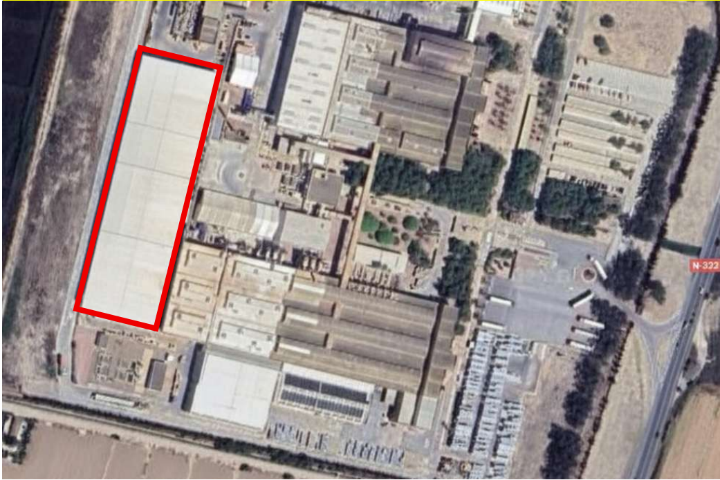
Figura 1 y 2: Situación de la nave industrial dentro del complejo
