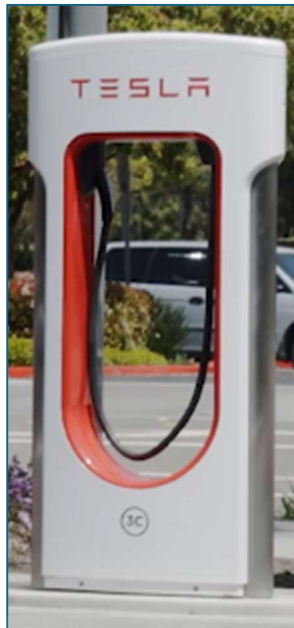
Ilustración 30: Tesla V2 150 kW ultrarrápida CC
