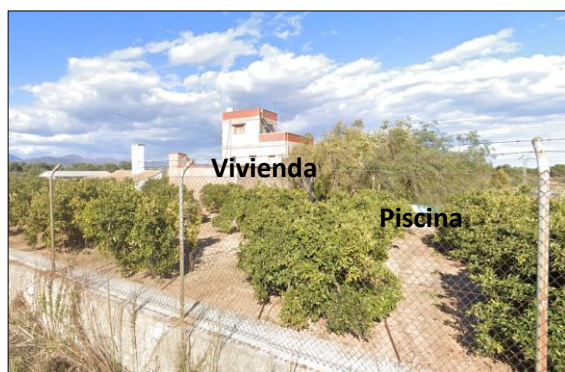
Figura 1. Edificaciones vistas desde el sur.
