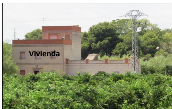
Figura 2. Edificaciones vistas desde el este.
