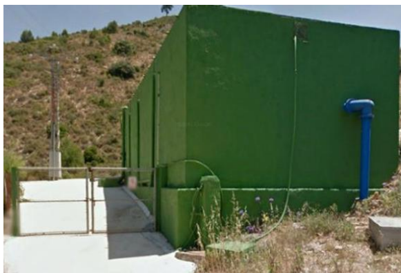
Imagen 8.3.12– Depósito de cabecera y depósito regulador de la red de abastecimiento.
