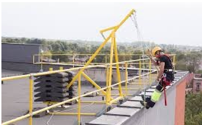
Imagen 8: trabajo vertical mediante cuerdas. (Imagen obtenida en la página web https://orionseguridad.es/producto/pescante-para-trabajos-verticales/ )
