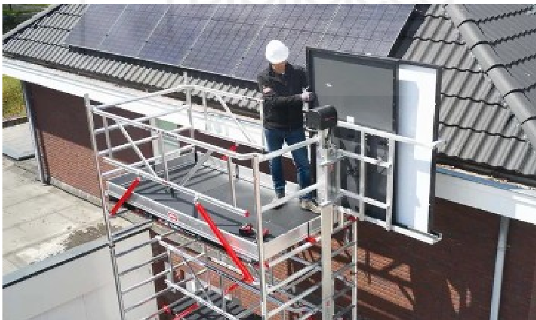
Imagen 7: andamio para realizar instalación de placas fotovoltaicas sobre vivienda. (imagen obtenida de la página web https://altrex.com/es_ES/andamios-de-aluminio/shuttle )
