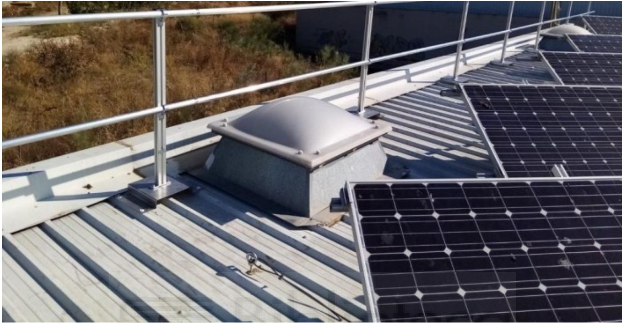
Imagen 2: Instalación de placas sobre cubierta. Barandillas de seguridad. (Imagen obtenida de la página web https://escayolasbedmar.com/productos/sistemas-para-cubiertas-y-fachadas/claraboyas-y-lucernarios/ )
