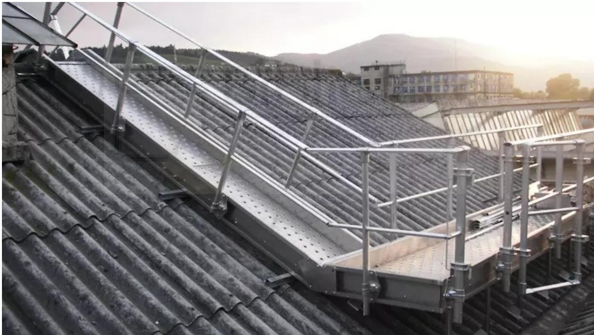
Imagen 10: Sistema de pasarela con barandilla de protección a ambos lados y con puerta de acceso abatible.
