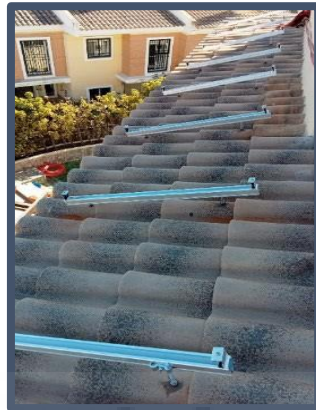
Figura 6 Perfiles metálicos sobre cubierta
