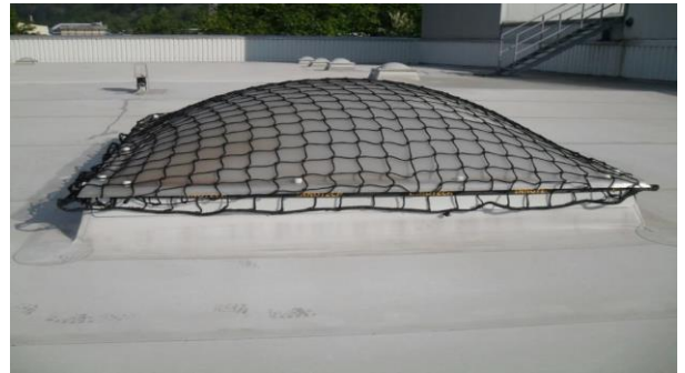
Figuras 39, 40 y 41 Sistemas de protección de claraboyas y lucernarios
