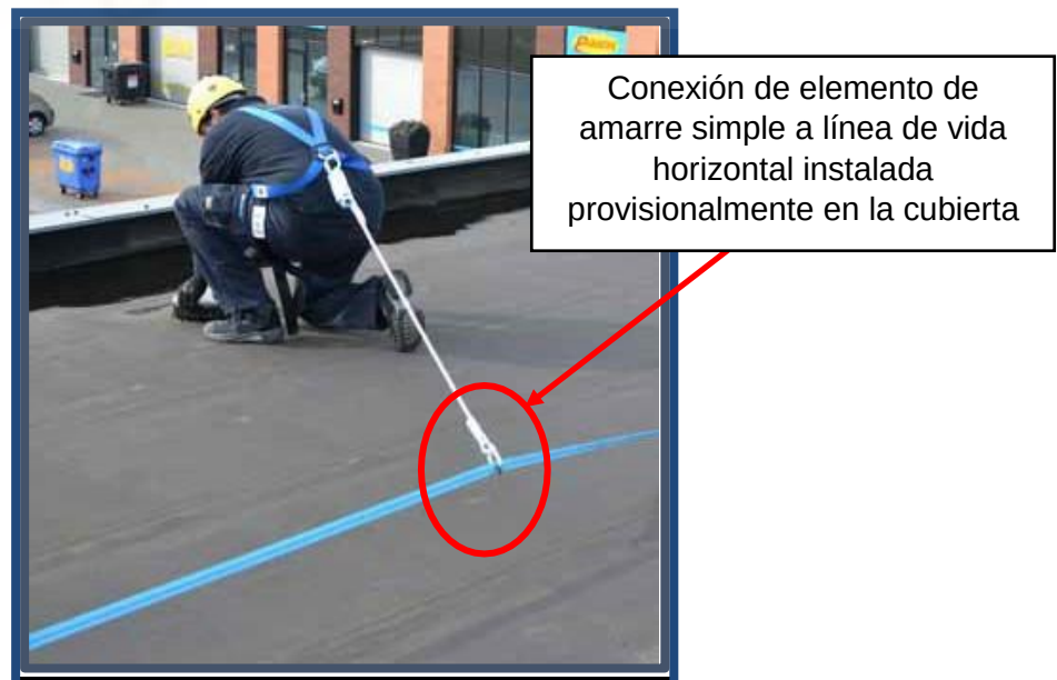
Figura 32 Elemento de amarre simple a línea de vida
