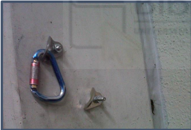
Figuras 15 y 16 Anclajes mecánicos (izquierda) y anclaje químico (derecha)
