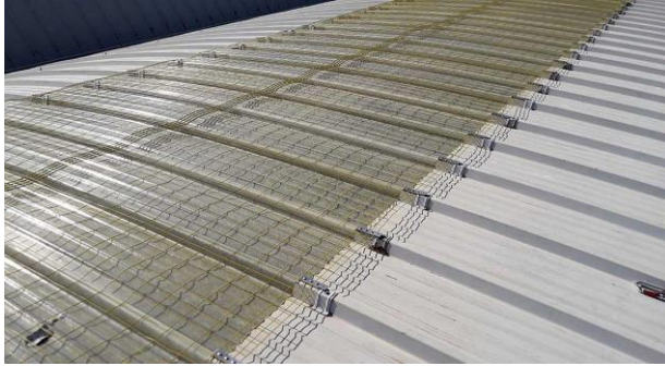
Figuras 39, 40 y 41 Sistemas de protección de claraboyas y lucernarios
