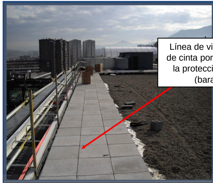
Figuras 19 y 20 Línea de vida horizontal de cinta
