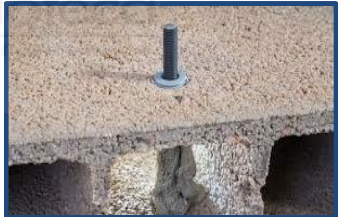
Figuras 15 y 16 Anclajes mecánicos (izquierda) y anclaje químico (derecha)
