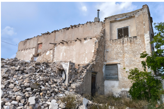
Imagen 11. Fotografía actual de un derrumbe en Almarra. Fuente: Elaboración propia.
