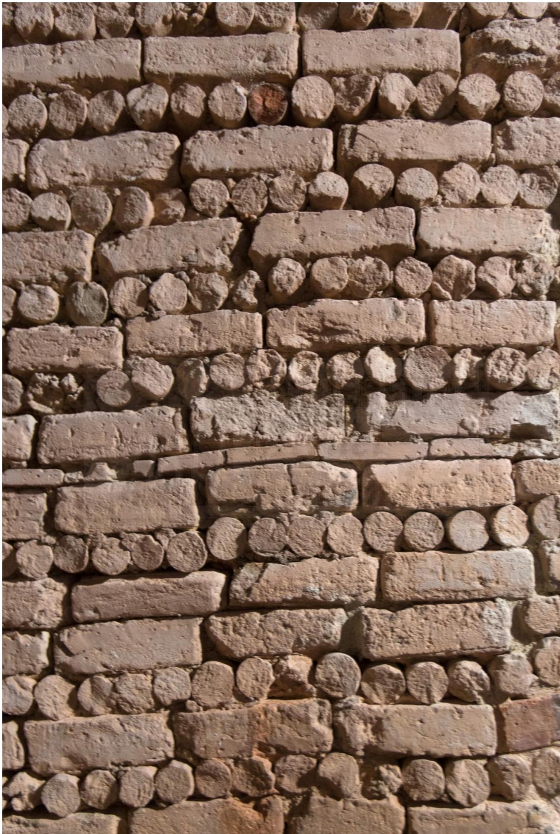
Fig. 2. Detalle pared interior horno 1. Se aprecia la disposición de los ladrillos y los birlos en su construcción que lo hace único en los hornos tradicionales que aún quedan en pie. Foto: Jose María Hortelano.
