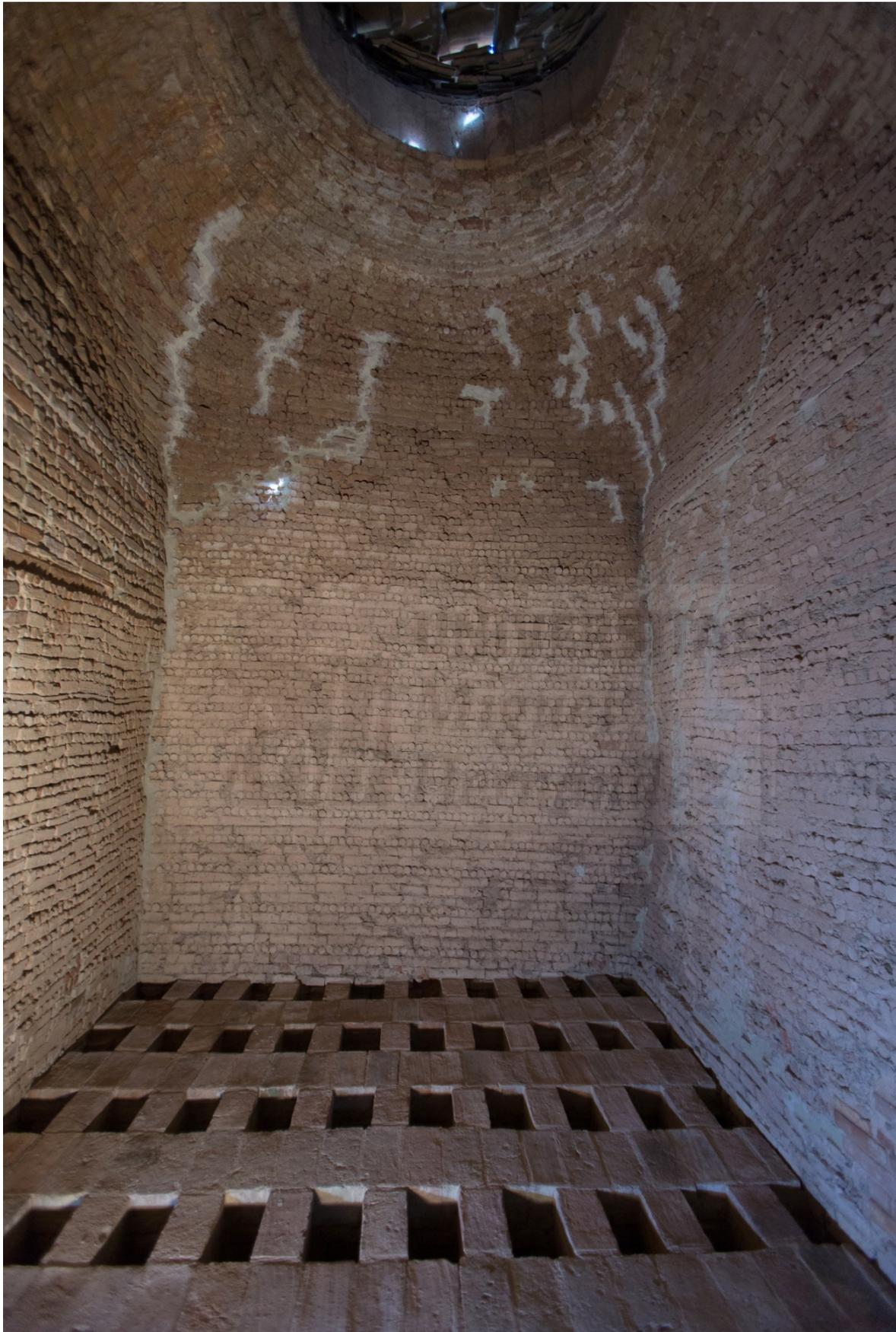
Fig. 1. Horno 1. Cámara de cocción: detalle la rejilla, cúpula y óculo de ventilación. Foto: Jose María Hortelano.
