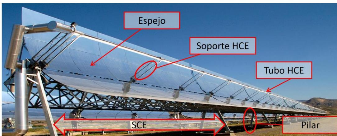
Figura 19. Vista en perspectiva del Solar Collector Element (Elemento Colector Solar) SCE
