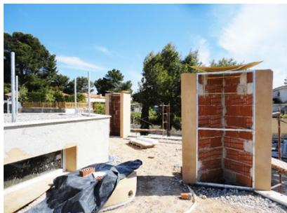
Fig. 4. Fotografía de la chimenea solar.
