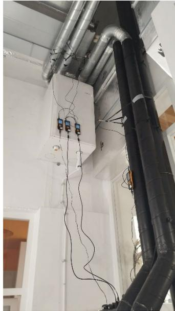
Fig. 10. Fotografía de la toma de datos en el equipo mecánico de ventilación.
