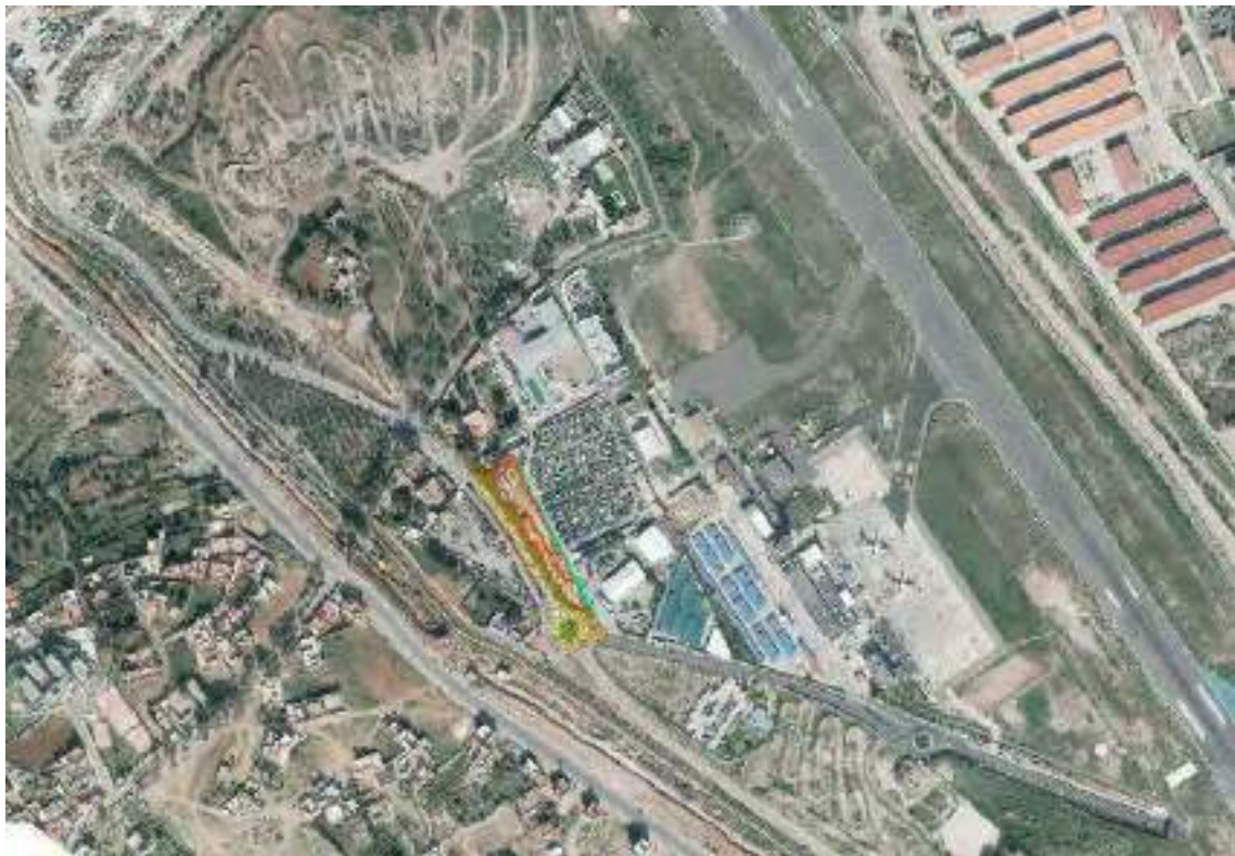
Fig.1: Foto Aérea de la zona.
