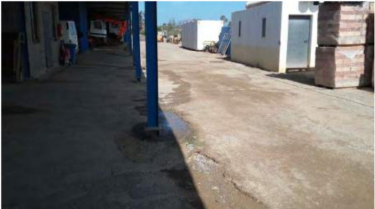
ESTRUCTURA DEL HANGAR
