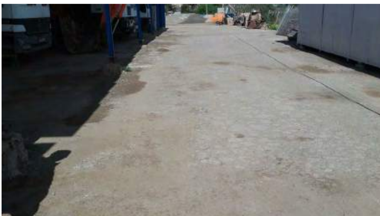
PAVIMENTO DE HORMIGON
