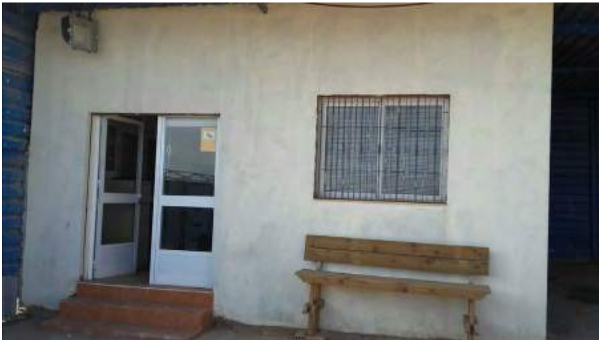
EDIFICIO DE OFICINAS
