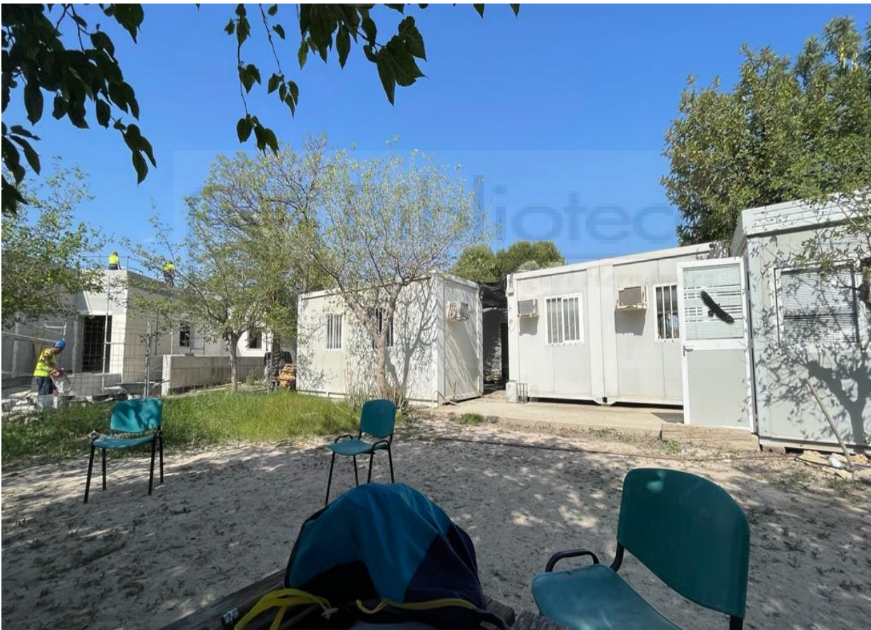
Imatge 4. A l'esquerra, obra de construcció de les futures instal·lacions del centre. A la dreta, mòduls prefabricats actuals.
