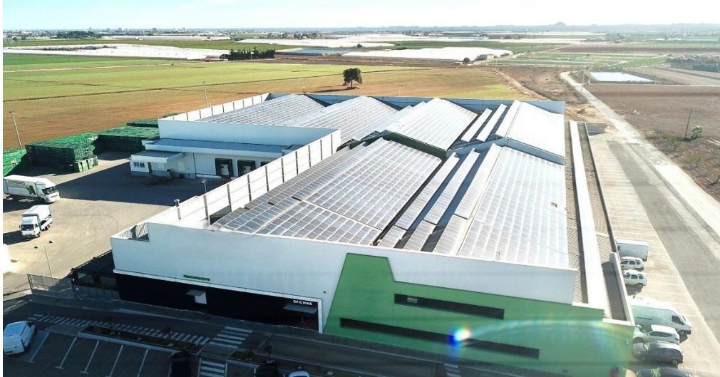
Foto 1. Fotografía del exterior de la nave.
