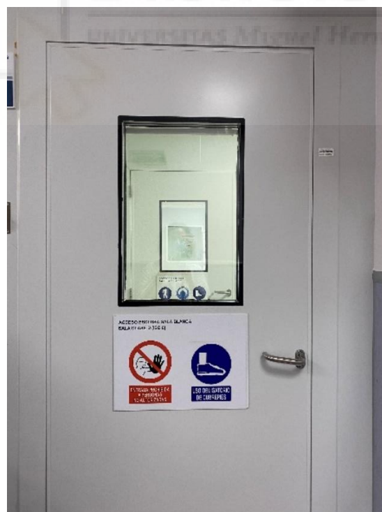
Imagen 6: acceso a exclusas de preparación
