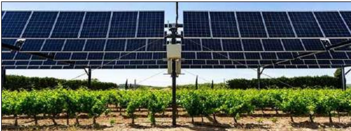
Figura 5.3. Sistema “agrovoltaico” en altura sobre el viñedo (Piolenc, Francia)
