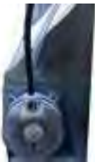
Presostato diferencial de aire.
