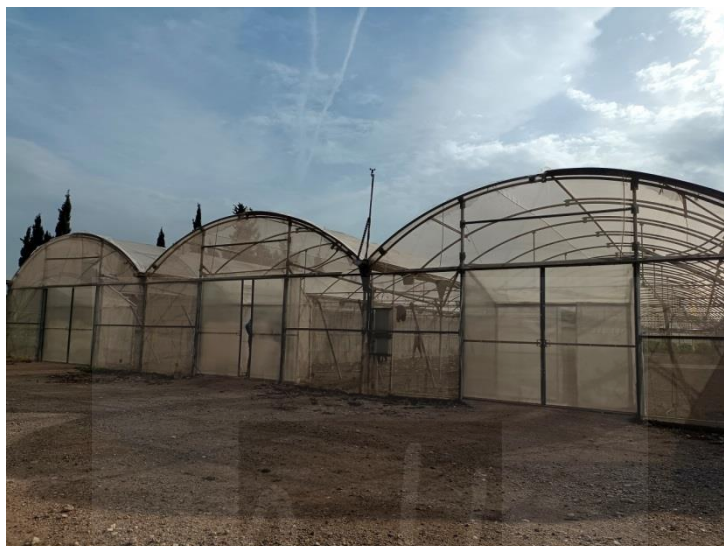
Figura 11. Detalle de las instalaciones donde se realizó el ensayo. Fuente: elaboración propia.
