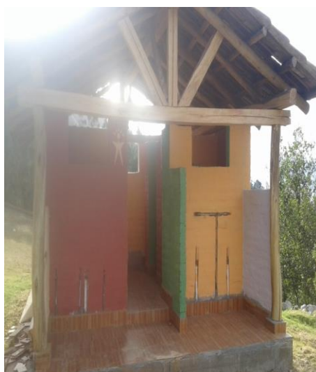
Ilustración 47: Sanitario comunitario al lado de la iglesia.
