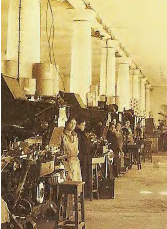
Figura 2. Fotografía fábrica de Tabaco de Alicante.
