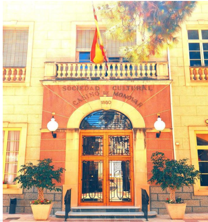
Ilustración 10. Fachada del actual Casino. Fuente propia
