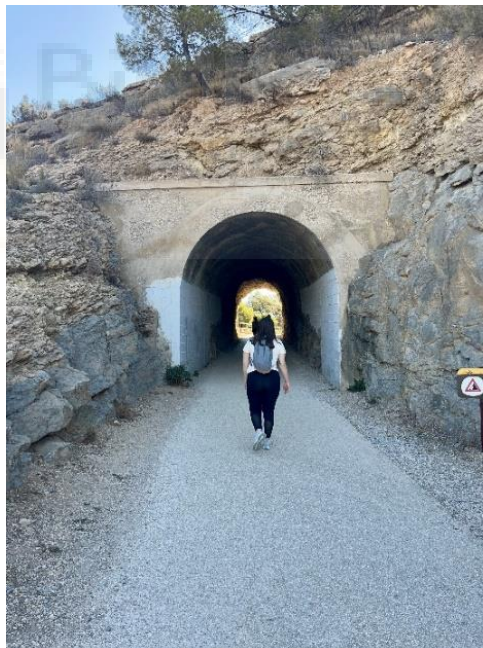
Figura 9. Actual túnel y camino del faro construido en 1961.
