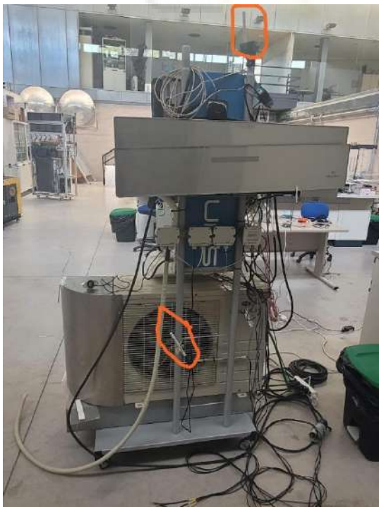
Figura 3.22: Termohigrómetros colocados para medir la humedad ambiental y del aire de salida del equipo.
