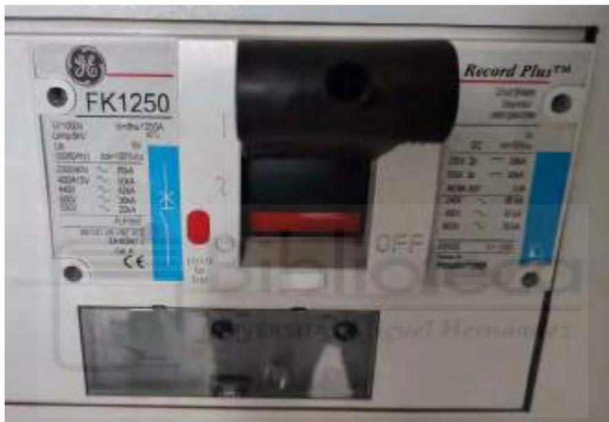
*Ilustración 21. Protección magnetotérmica general del CGPBT de la nave industrial.*
