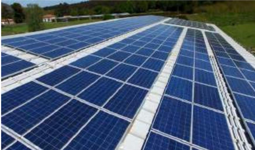
*Ilustración 16. Foto ejemplo instalación coplanar.*
