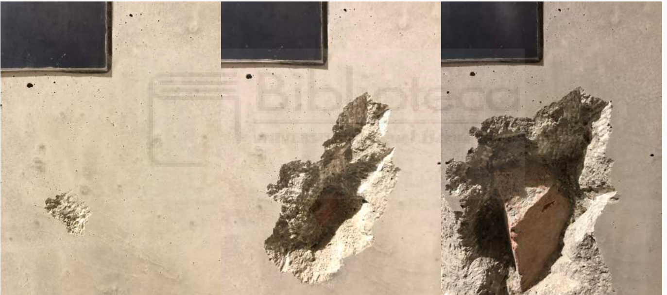
Figura 33. Proceso de talla de hormigón.
