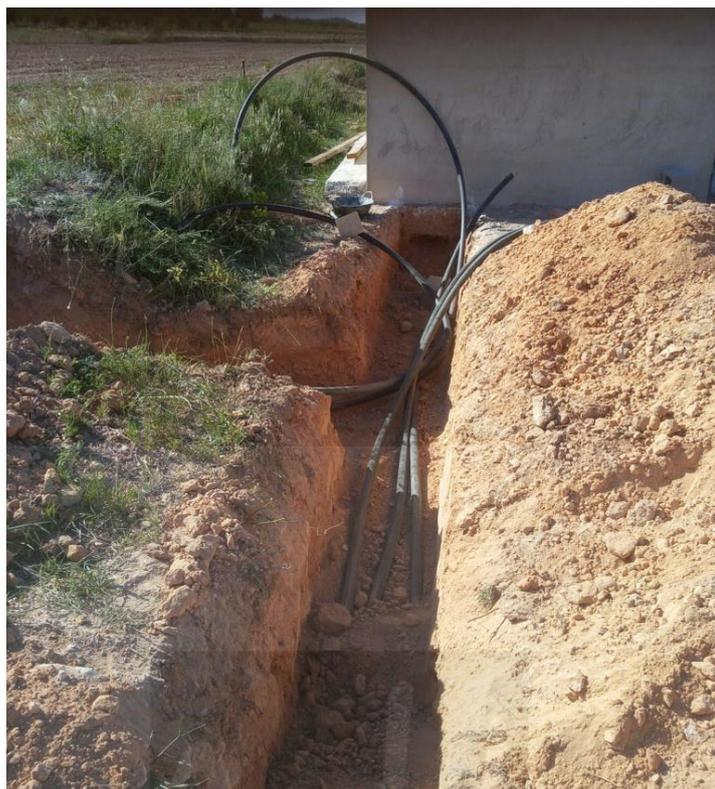
**Fotografía 19.** Detalle de tuberías de conexión desde la red general hasta el cabezal de riego (elaboración propia).
