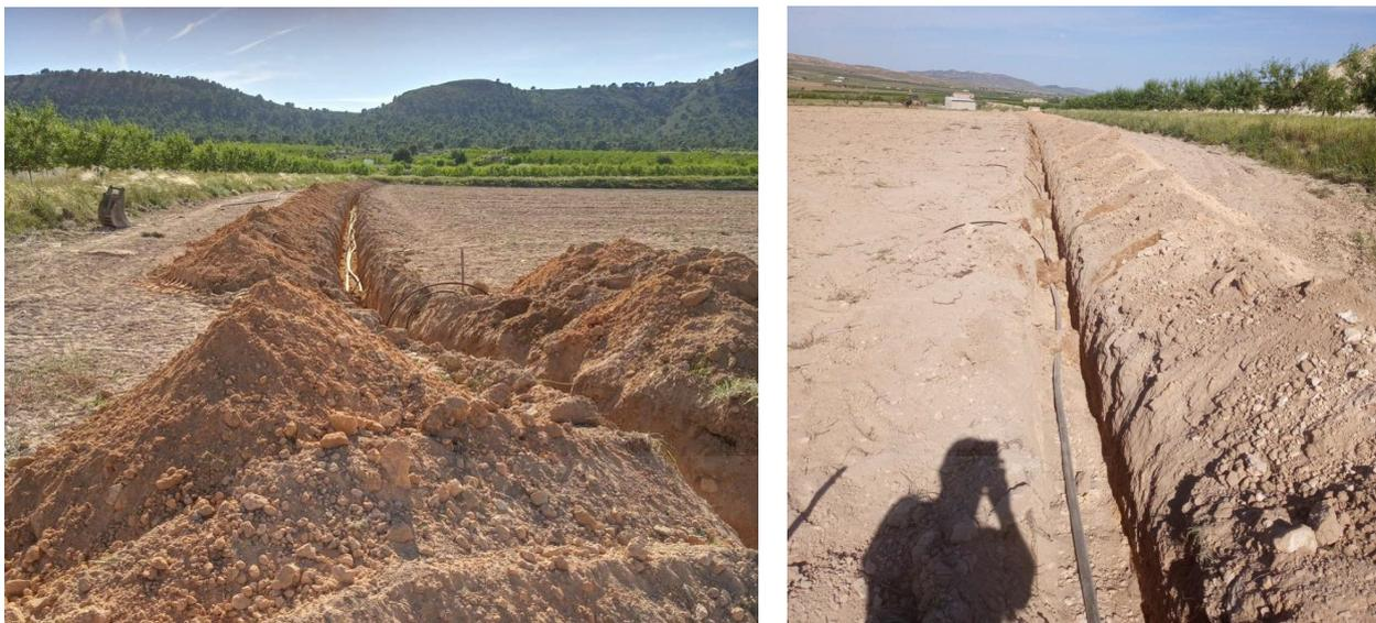
**Fotografías 20 y 21.** Detalle de distribución de tuberías terciarias en la parcela (elaboración propia).
