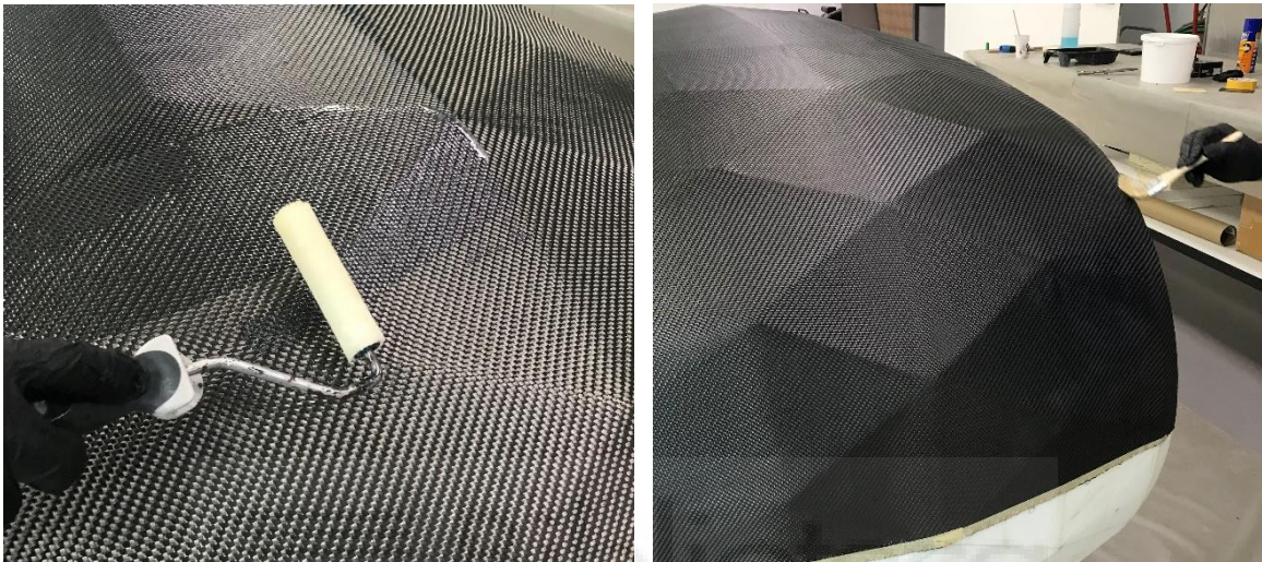
Figura 15. Impregnación de la capa de fibra de carbono
